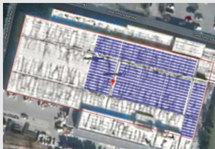
POSTAVITEV MODULOV SONČNE ELEKTRARNE MERKUR VELENJE.
