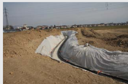
OB REKONSTRUKCIJI 110/20 KV RAZDELILNE TRANSFORMATORSKE POSTAJE ŠKOFJA LOKA SE JE UREDILO VEČ KOT 600 METROV TRASE PRIKLJUČNEGA 110 KV KABLOVODA. Foto: Tomaž Šitar
