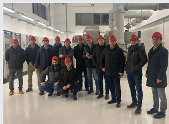
DELEGACIJA IZ MOLDAVIJE NA OGLEDU 110-KILOVOLTNEGA STIKALIŠČA GIS V RTP ŠKOFJA LOKA.
