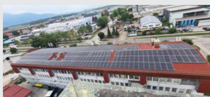
SONČNA ELEKTRARNA NA STARI STAVBI DRUŽBE ELEKTRO GORENJSKA. Foto: Robert Jošt
