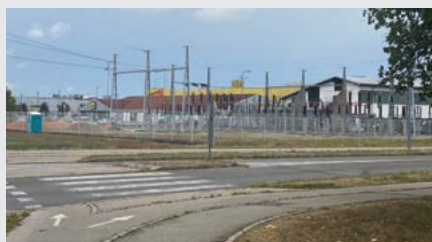
OBNOVA RTP PRIMSKOVO JE POTEKALA PO FAZAH. Foto: Arhiv Elektra Gorenjska
