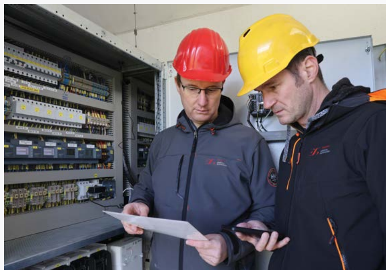
Digitalna transformatorska postaja ekipam obratovalcev omogoča vpogled v dejansko stanje na postaji ter podatke o električnih veličinah in stanjih varovalk na izvodih, prav tako pa tudi analitiko in načrtovanje omrežja.
