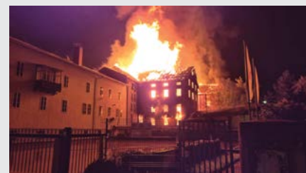
POŽAR V HIDROELEKTRARNI SAVA. Foto: Aleks Jan
