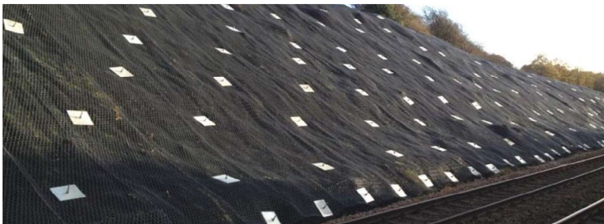
Slika 2: sidranje protierozijske mreže.
