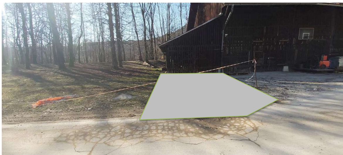
Slika 2: Razširitev asfaltnega platoja pred skladiščem
