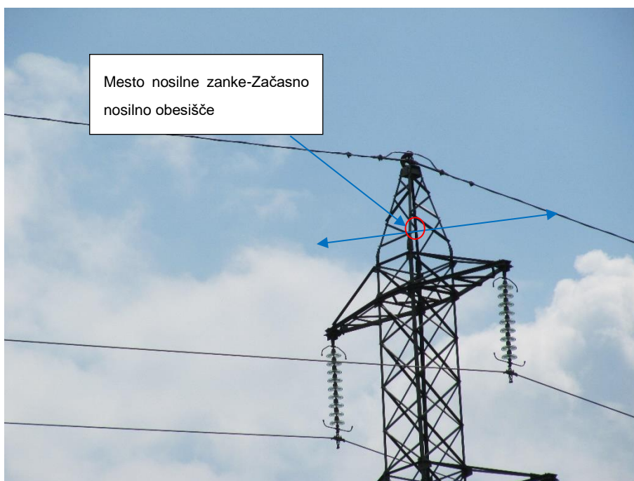
Slika 2: Prikaz lokacije pomožnega obesišča na nosilnem stebru.
