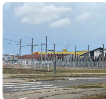
↑ Obnova RTP Primskovo je potekala po fazah Foto: Arhiv Elektra Gorenjska
