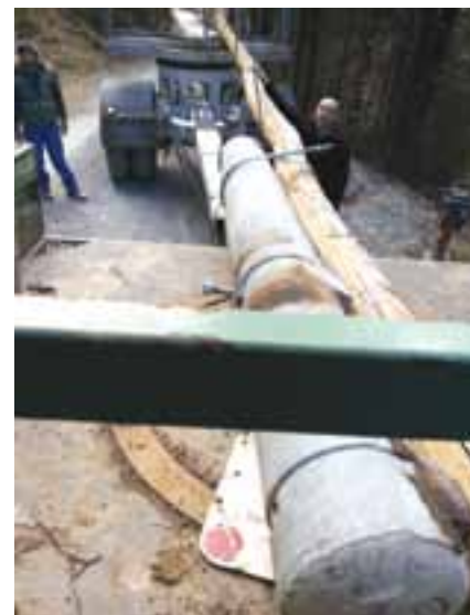
Dolžina tovora se skrajša, če drogovnik obrnemo za 180 stopinj in ga pritrdimo z obstoječim vijakom in objemko, ✉ Bojan Maček
