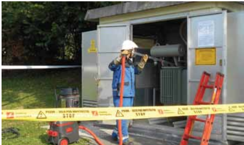
Izvajanje čiščenja transformatorske postaje z metodo DPN, © Aleš Nagode
