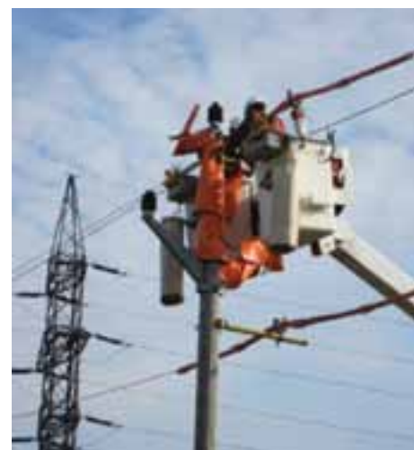
Praktičen primer izvajanja DPN na SN (zamenjava izolatorjev) podjetja Bayernwerk iz Nemčije, ki je bila prikazana na mednarodni konferenci na temo DPN na Češkem, © Gregor Štern
