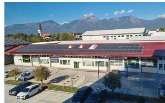
Moduli so na garažah nameščeni po jugozahodni strešini Foto: Arhiv Elektra Gorenjska
