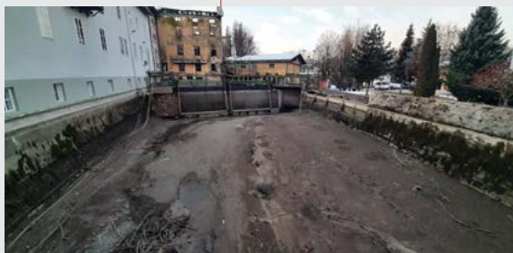
DOVODNI KANAL HIDROELEKTRARNE SAVA BO IZPRAZNJEN NAJMANJ LETO IN POL
