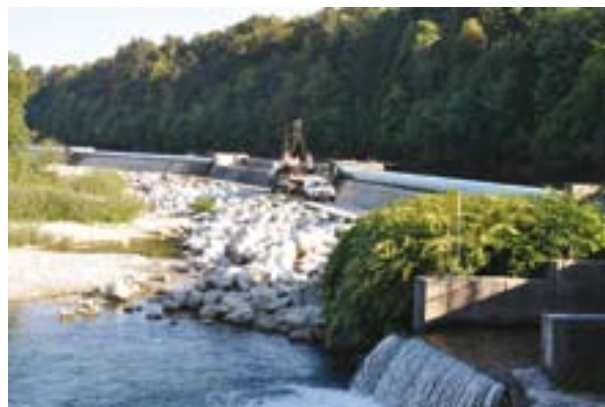
Priprava za montažo gumene membrane
