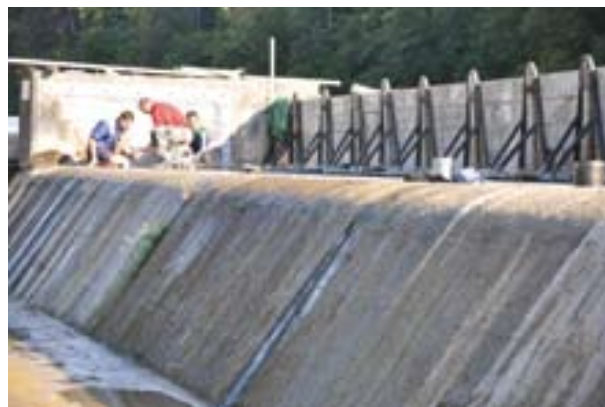
Tesnjenje prirobnice polnilnega kanala gumene membrane
