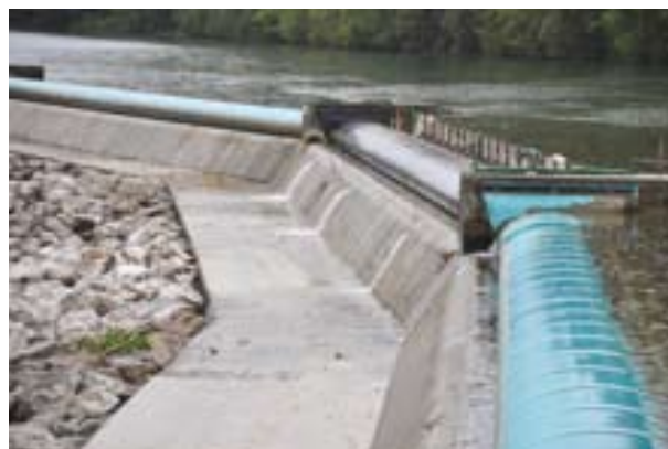
Kontrola tesnjenja gumene membrane pred prevzemom
