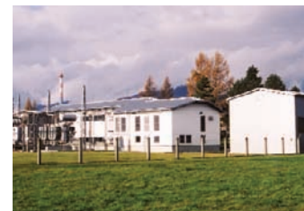
Stavba RTP Labore z nadomestnim stikališčem GIS izvedbe, leta 2002 (foto Drago Papler)
