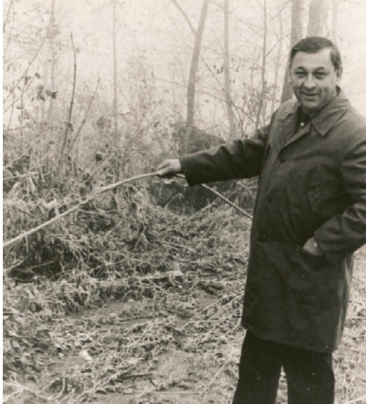
Janko Potočnik ob ogledu poškodb na 10 kV daljnovodu ob reki Sori v Medvodah v času poplav leta 1990 (foto Drago Papler)
