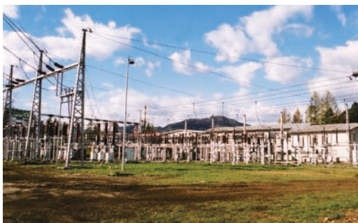
Stikališče RTP Labore pred rušitvijo zunanjega 110 kV stikališča leta 2001 (foto Drago Papler)
