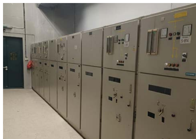
OPREMA NOVEGA 20 KV STIKALIŠČA SO MODERNE CELICE V SF 6 IZVEDBI PROIZVAJALCA ORMAZABAL, VODENJE IN ZAŠČITA PA PROIZVAJALCA SIEMENS GENERACIJA SIMATIC/SIPROTEC
