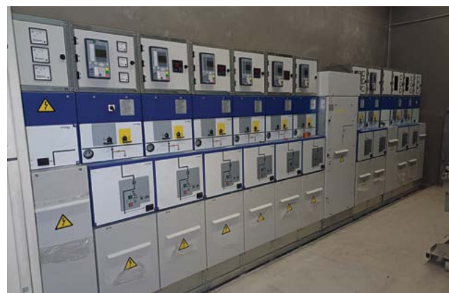
OPREMA NOVEGA 20 KV STIKALIŠČA SO MODERNE CELICE V SF 6 IZVEDBI PROIZVAJALCA ORMAZABAL, VODENJE IN ZAŠČITA PA PROIZVAJALCA SIEMENS GENERACIJA SIMATIC/SIPROTEC
