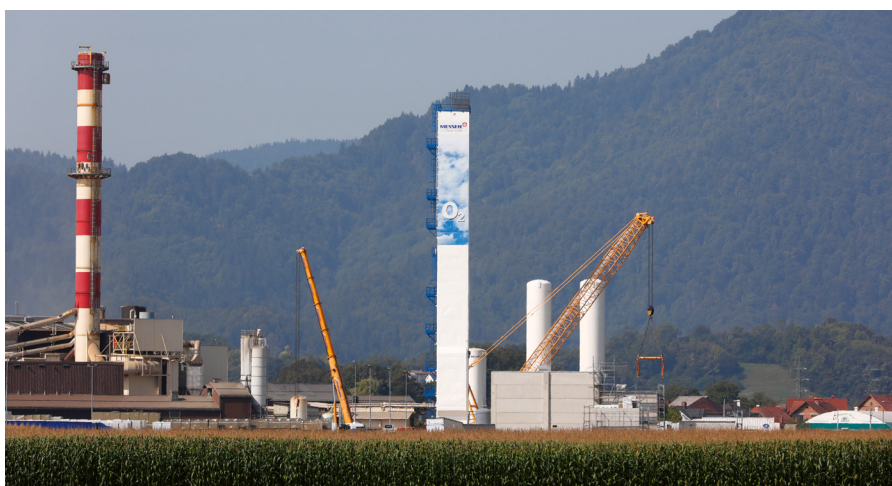
Kisikarna Messer v izgradnji
