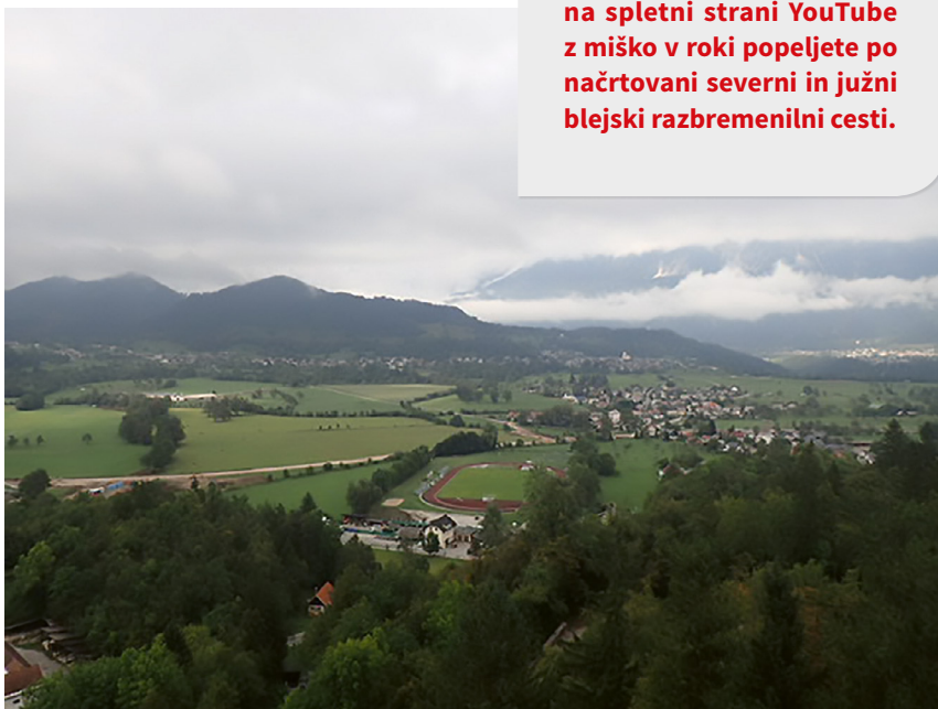
Zahodni del severne blejske obvoznice, ki je v grobem že zgrajena (pogled z Blejskega gradu)
