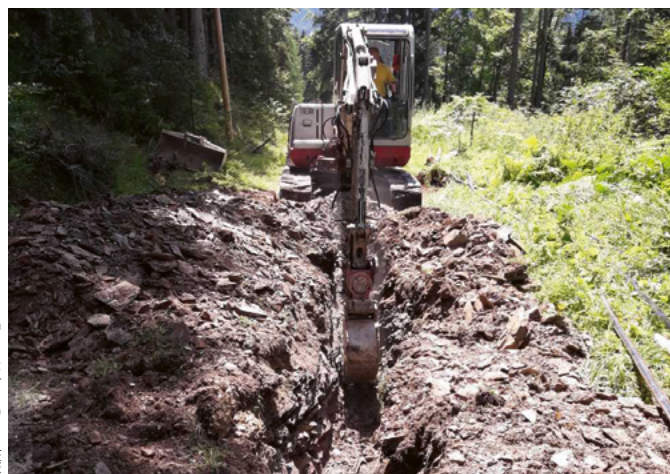
Kablitev 20-kilovoltnega daljnovoda na Jezersko
