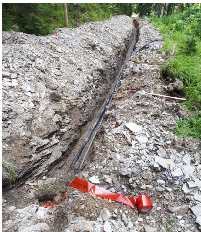
Izgradnja 20 kV kablanskega kablovoda med kraji Mojstrana – Radovna – Kreda – Gorje
