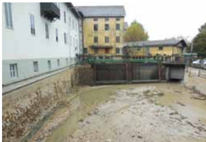
Iz dovodnega kanala pred vtokom v hidroelektrarno Sava so bili odstranjeni nanosi materiala, doc. dr. Drago Papler
