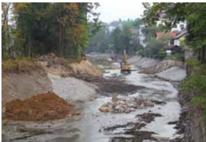
Sanacijo dovodnega kanala HE Sava je izvajalo Vodnogospodarsko podjetje Kranj, doc. dr. Drago Papler
