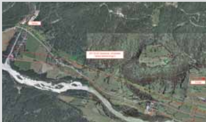
Letošnja faza rekonstrukcije je potekala med naseljema Belca in Dovje
