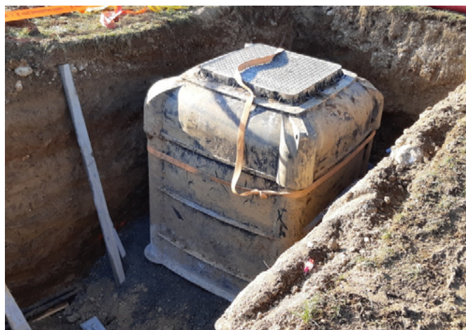
Vgradnja PVC-jaškov pri RP Naklo
