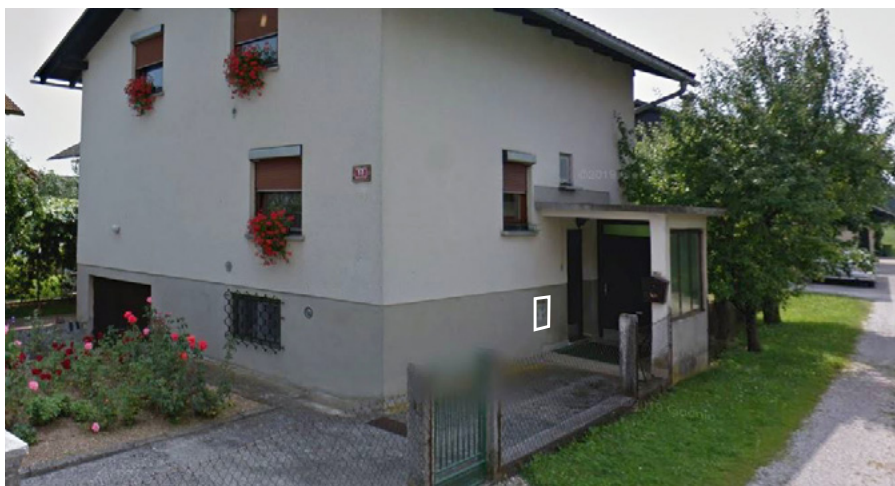
Priključna omarica na fasadi, za ograjo, števec v stanovanju
