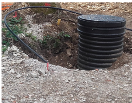
Urejeno odvajanje odpadnih voda pri objektu RP Naklo
