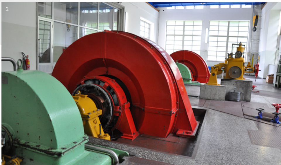
1 Stavba hidroelektrarne Savica
