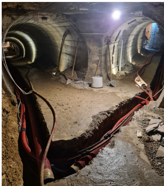
Polaganje kableske kanalizacije za optiko in elektro kable
