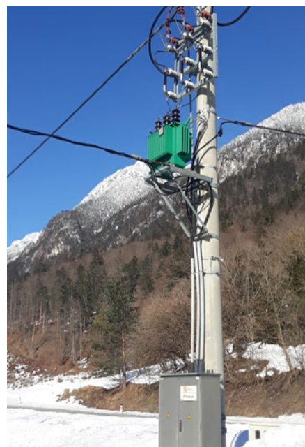
Transformator s hladilno in izolacijsko tekočino MIDEL
