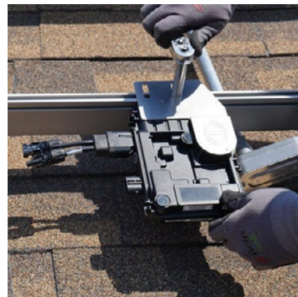
Montaža mikrorazsmernika Enphase
