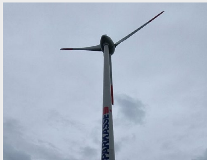
Vetrna elektrarna Razdrto
