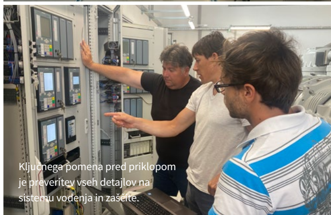
Novo moderno kovinsko oklopljeno, s plinom SF 6 izolirano GIS-stikališče ter omare vodenja in zaščite v GIS-stikališču.
