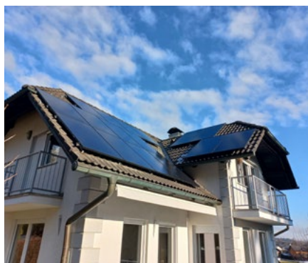
Postavljena sončna elektrarna
