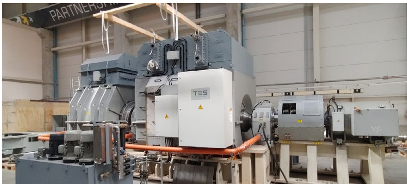
Postrojenje za projekt TOKAMAKA
