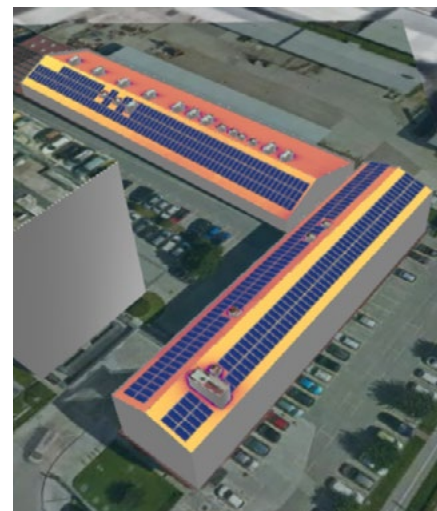
Postavitev sončne elektrarne na stari stavbi in na garažah družbe Elektro Gorenjska
