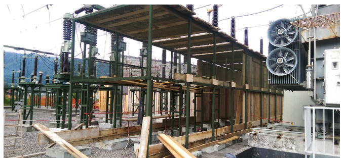
Začasni zaščitni »tunel«
