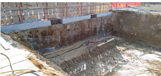
Izvedba zaščite gradbene jame s tehnologijo jet-grouting
