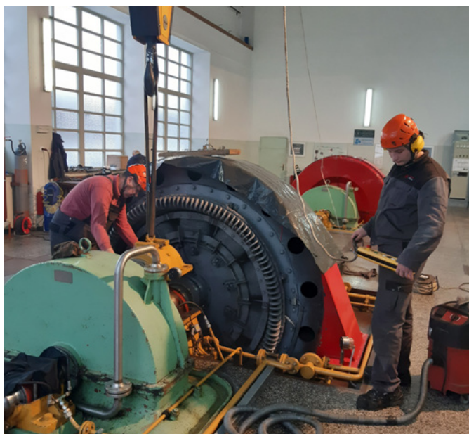
Revizija hidroelektrarne Savica
