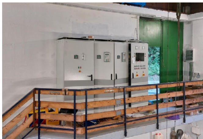
Obnova v hidroelektrarni Zvirče
