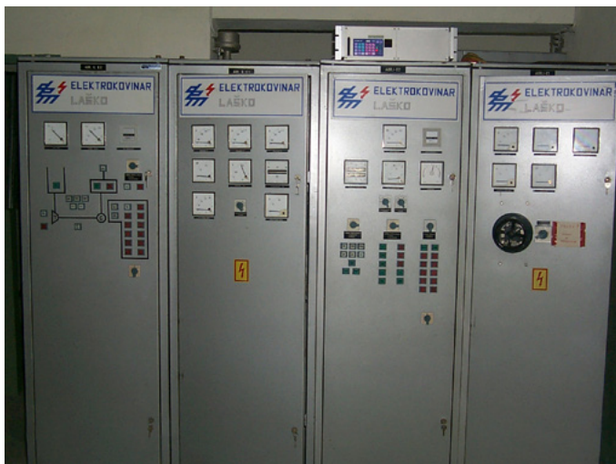
V relejni tehniki izdelan sistem vodenja iz leta 1986 smo zamenjali z modernim upravljalnim sistemom.
