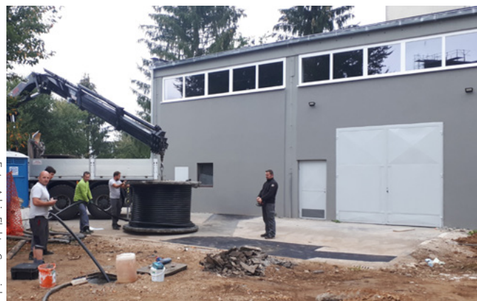
Elektro dela v novi kotlovnici na območju kampusa Zlato polje so potekala po planu
