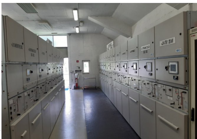
Razširjeno 20 kV stikališče v RTP Kranjska Gora
