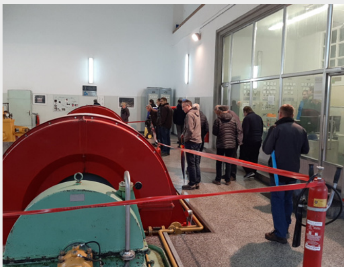
Na ogledu hidroelektrarne Savica
