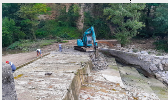
Sanacijska dela na hidroelektrarni Standard
