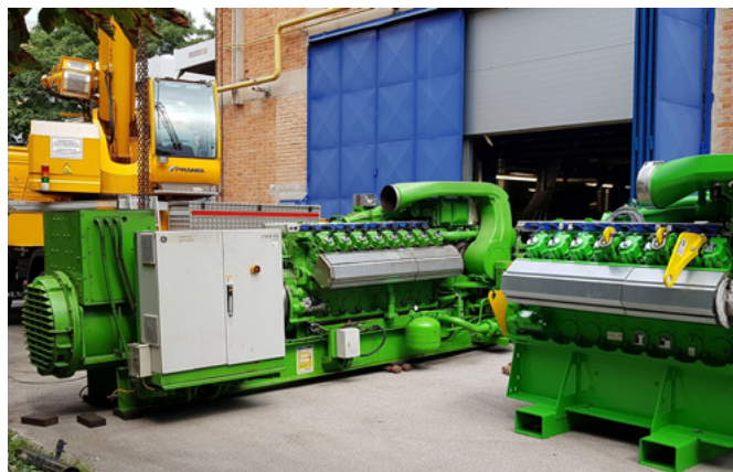
Zamenjava glavnega pogonskega agregata proizvodne naprave SPTE Planina
