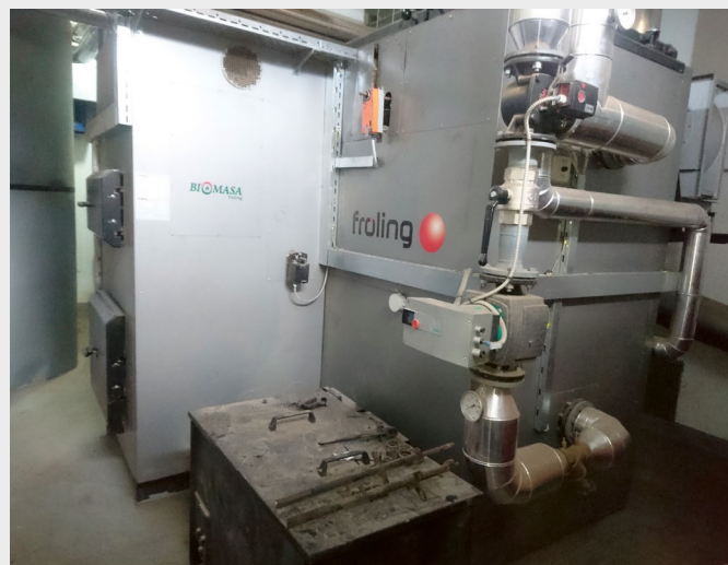
Kotlovnica na lesno biomaso v Tržiču moči 500 kW
