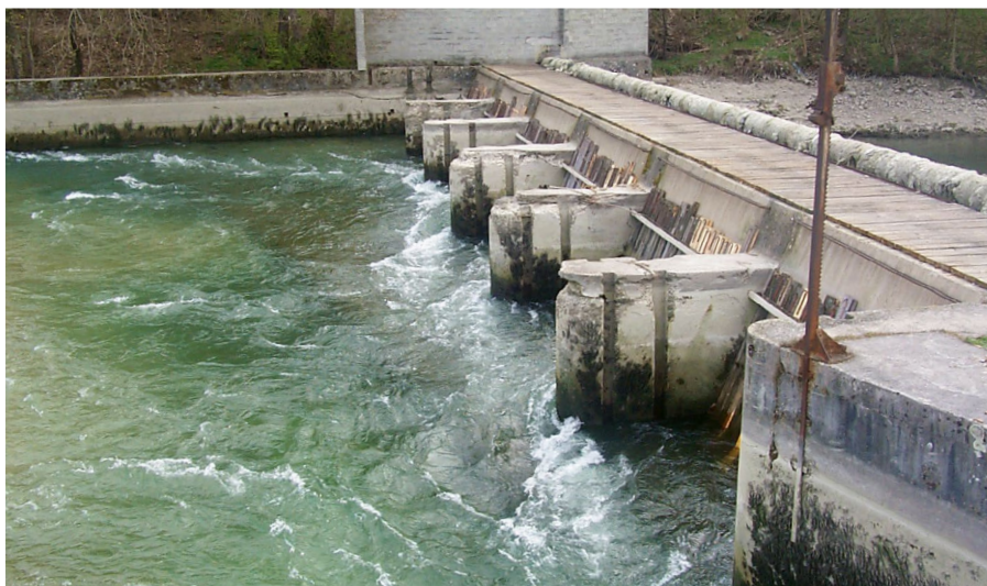
Vtok v energetskega kanal
