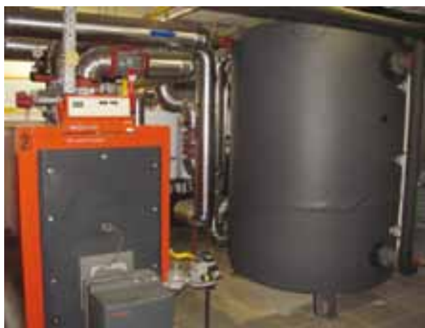
Stari kotel in nov hranilnik toplote
