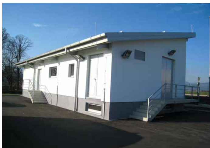
Energetski objekt RP Trata bo pripomogel k zanesljivi oskrbi z električno energijo v hitro rastoči industrijski coni Trata, Jurij Podpečan
