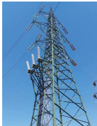
NADGRADNJA DALJNOVODNEGA STEBRA V RTP PRIMSKOVO
