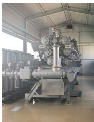
110 kV GIS STIKALIŠČE Z NOVO SEKUNDARNO OPREMO
