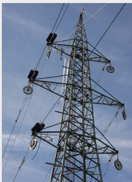
Na 110 kV daljnovodu Bled–Bohinj potekajo vzdrževalna dela
