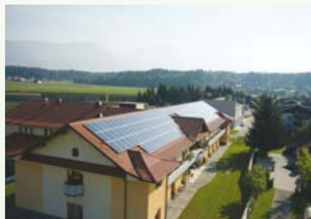
SE na strehi športne dvorane na Trati v Škofji Loki, Arhiv Gorenjskih elektrarn
