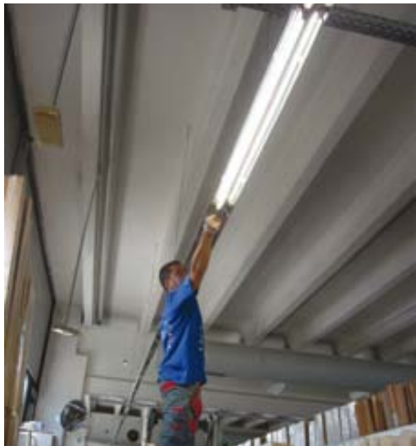
Montaža novih svetilk
