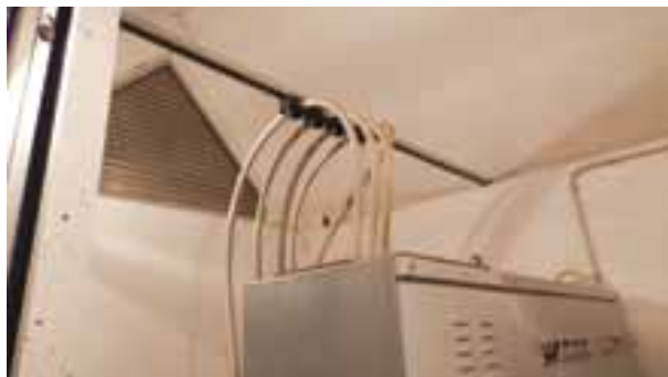
Prečni nosilec z montiranimi kabljskimi objemkami in NN-povezavo s transformatorja na nizkonapetostno razdelilno ploščo
