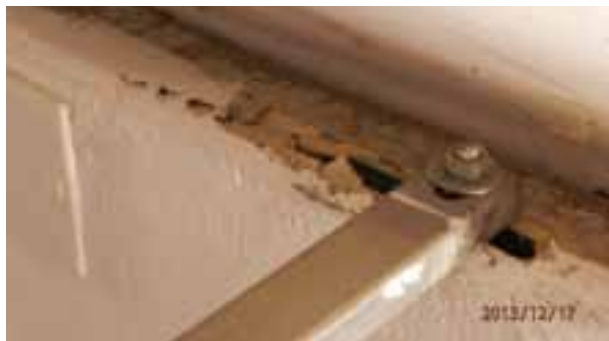
Predhodno v beton vlit vzdolžni nosilec
