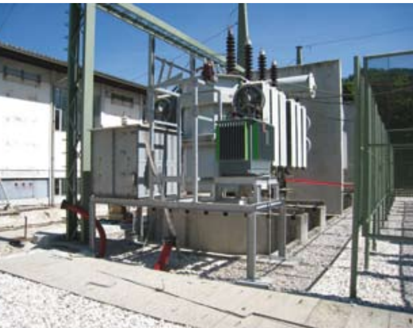
Vgradnja SN dušilke v RTP Jesenice, Jurij Podpečan
