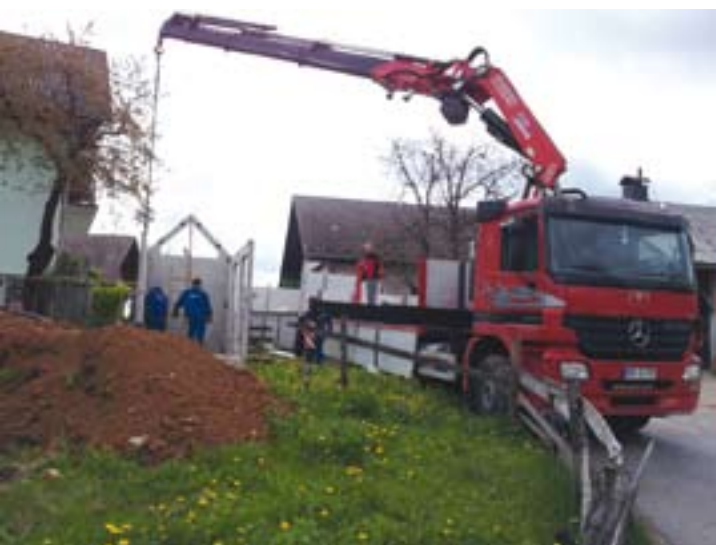
Montaža transformatorske postaje TP Hudo, Arhiv Elektra Gorenjska
