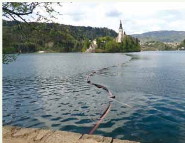
Polaganje nizkonapetostnega kabla na blejski otok, 📷 Anže Vilman
