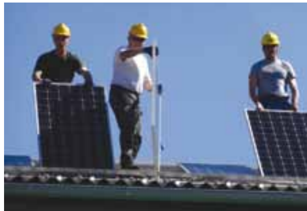
Ekipo pri postavljanju sončne elektrarne
