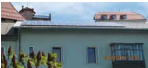
Poslovna stavba z novo kritino in sončno elektrarno
