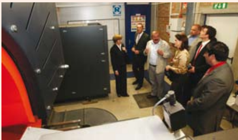
Na ogledu prenovljene kotlovnice Planina, 📷 Gorazd Kavčič
