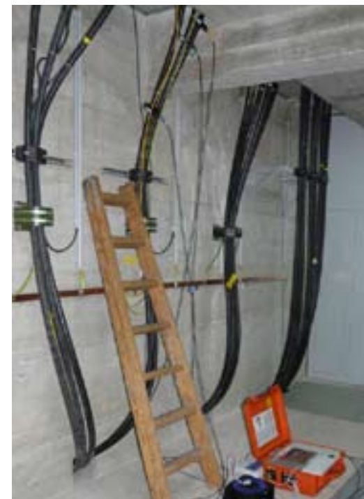
Slika 5: Namestitvev LPD-monitorja v RTP Škofja Loka, Viljem Bonča
