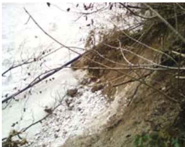
Poplave so na zgornjem Gorenjskem povzročile poškodbe na omrežju Elektra Gorenjska, Arhiv Elektra Gorenjska
