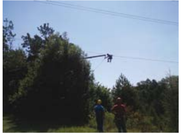
Na omrežju Elektra Gorenjska po temeljitih pripravih prvič v Sloveniji poteka zamenjava obstoječe optične telekomunikacijske povezave na 110 kV daljnovodu Moste-Bled, Arhiv Elektra Gorenjska
