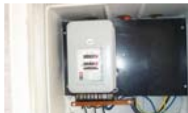
Držalo vodnikov se namesti na vodnike tik pod števcem
