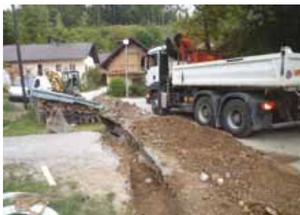
Izgradnja novega kabelskega omrežja na območju Dupelj, Arhiv Elektra Gorenjska
