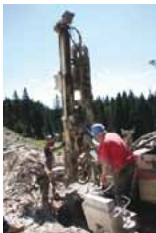
Začetek gradnje 110 kV daljnovoda Železniki – Bohinj, 📞 Arhiv Elektra Gorenjska
