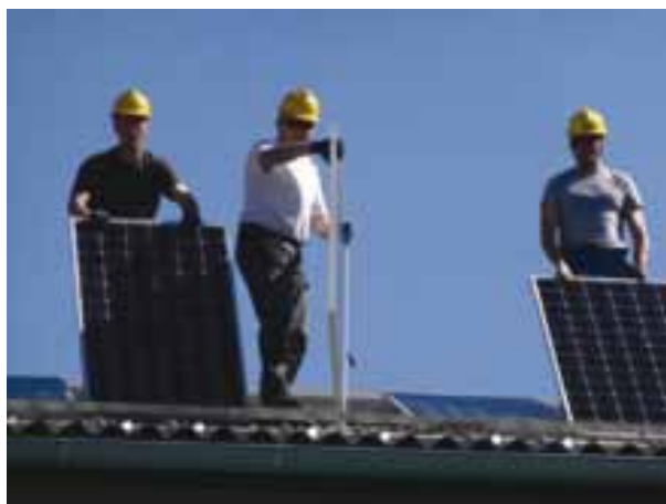
Postavljanje sončne elektrarne MFE GE, Iztok Jenko
