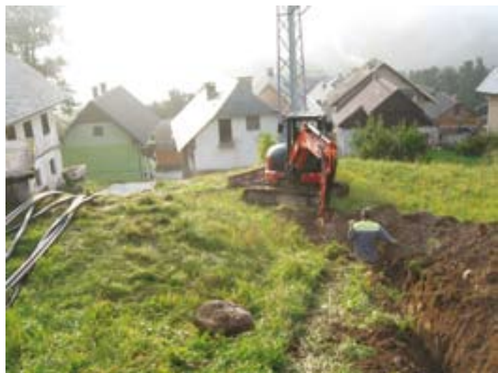
Izkop kabelskega jarka za 20 kV kablovod TP Zgornje Danje – TP Spodnje Danje, Arhiv Elektro Gorenjska
