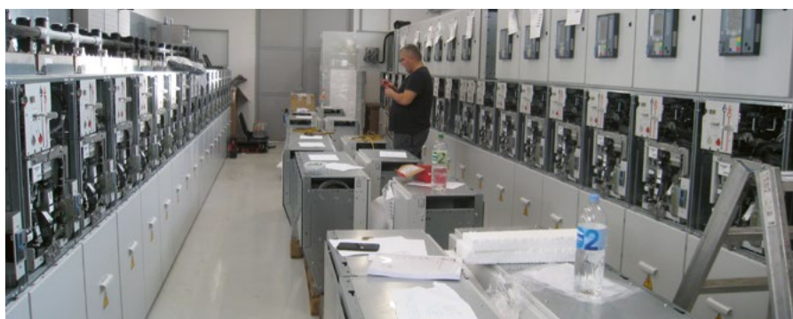
Elektromontažna dela v 20 kV stikališču RTP Brnik
