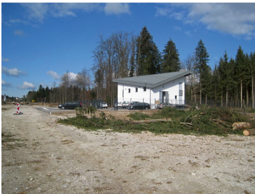
Nova stavba RP Brnik
