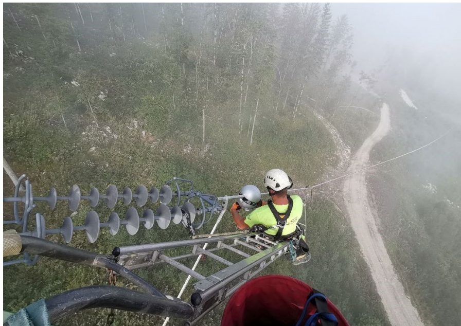
Montaža naprave Heimdall na 110 kV daljnovodu Železniki – Bohinj
