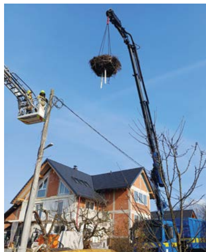
PRESTAVITEV ŠTORKLIJINEGA GNEZDA V PREDOSLJAH Foto: Arhiv Elektra Gorenjska
