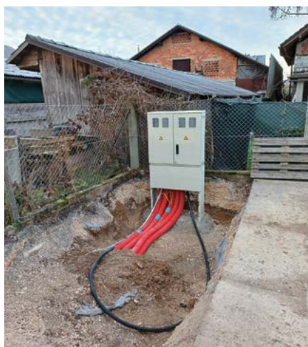
GRADNJA MERILNE OMARICE / FOTO: JAN VODNIK
