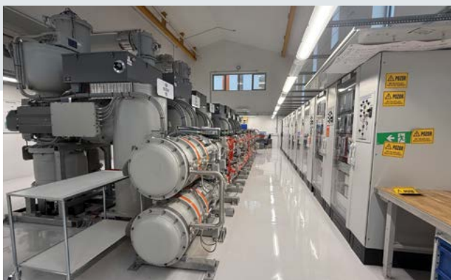
V STAVBI SE NAHAJA NOVO PLINSKO IZOLIRANO 110 KV STIKALIŠČE
