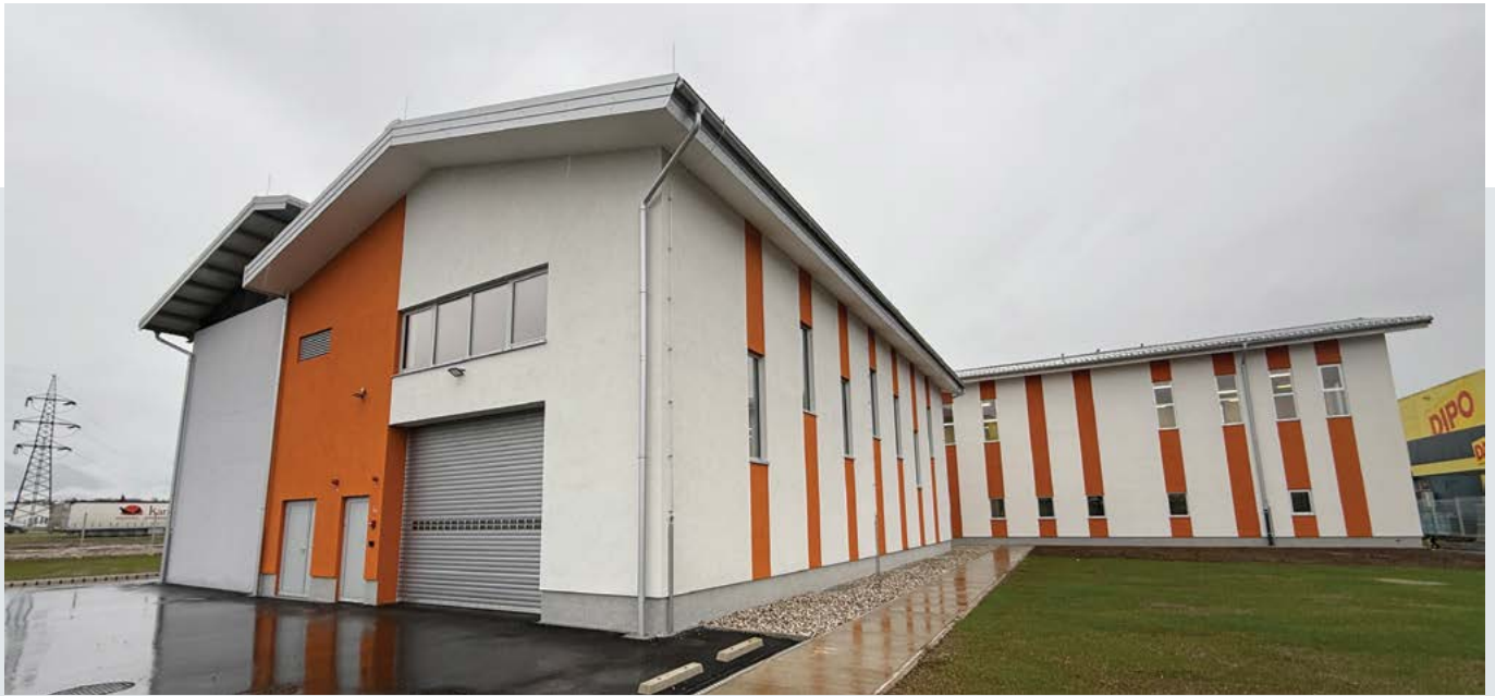
NOVA STAVBA RTP PRIMSKOVO
