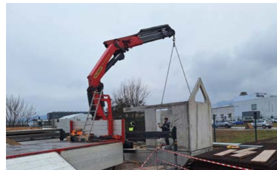
GRADNJA NOVE TP / FOTO: MATIC MAČEK
