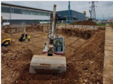
IZKOP GRADBENE JAME
