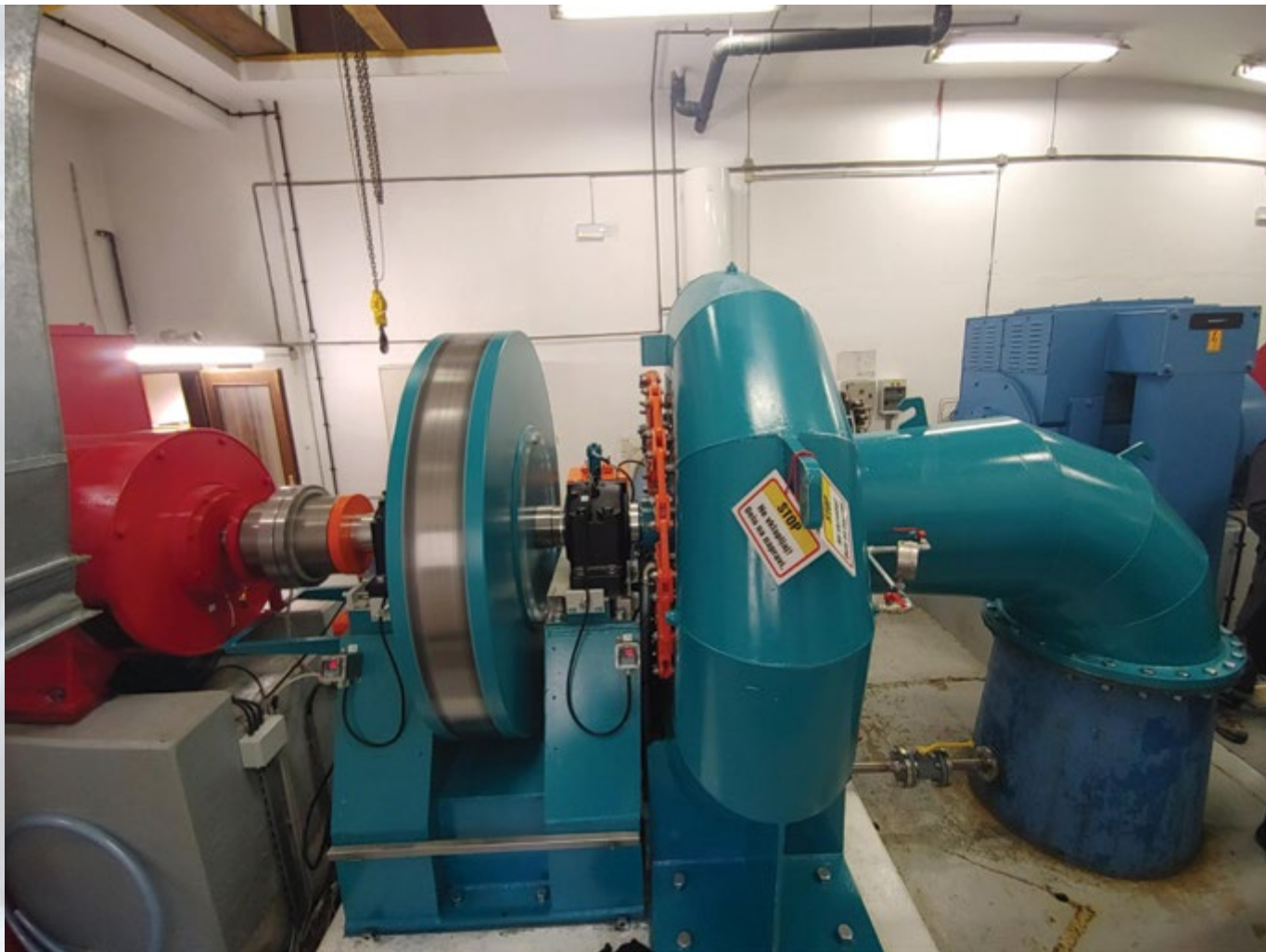
OBNOVLJEN AGREGAT 2 MED ZAGONSKIMI PREIZKUSI
