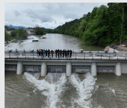
USPEŠNO ZAKLJUČENA SANACIJA LEVOOBREŽNEGA ZIDU DOVODNEGA KANALA IN OBNOVA MOSTU ČEZ KANAL PRI UPRAVNI STAVBI GORENJSKIH ELEKTRARN Foto: Arhiv Gorenjskih elektrarn
