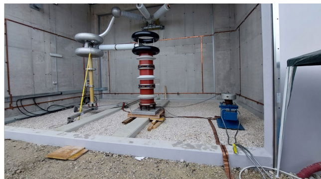
VISOKONAPETOSTNI TEST GIS-STIKALIŠČA
