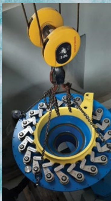
MONTAŽA TURBINE (VODILNIK S TURBINSKIM POKROVOM)
