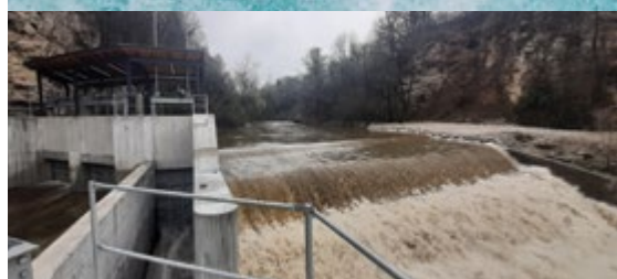
LEVO NOVI VTOČNI OBJEKT S PESKOLOVOM, DESNO JEZ
