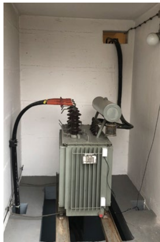
TEMPERATURNI SENZORJI SO BILI NAMEŠČENI NA NAŠE DISTRIBUCIJSKE TRANSFORMATORJE Foto: Arhiv Elektra Gorenjska
