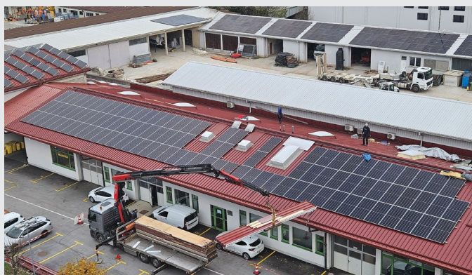
ZAMENJAVA DELA STREHE NA DELAVNICAH Foto: Arhiv Elektra Gorenjska
