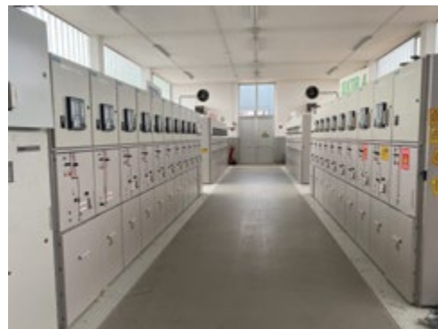
NADGRADNJA ENERGETSKEGA OBJEKTA RTP PRIMSKOVO Foto: arhiv Elektra Gorenjska
