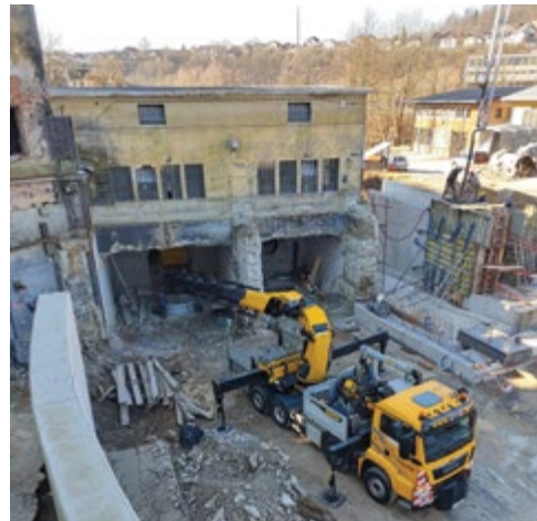
SANACIJSKA DELA V HIDROELEKTRARNI SAVA Foto: arhiv Gorenjskih elektrarn
