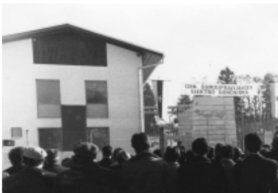
1980 RTP Radovljica, prvi distribucijski objekt 110/20 kV – Foto: Drago Papler
