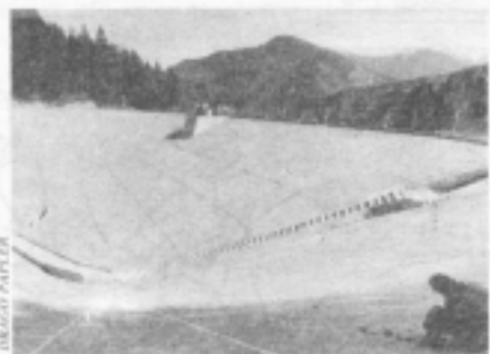
Akumulacijski bazen HE Lomščica so obdali s posebnim penobetonom
