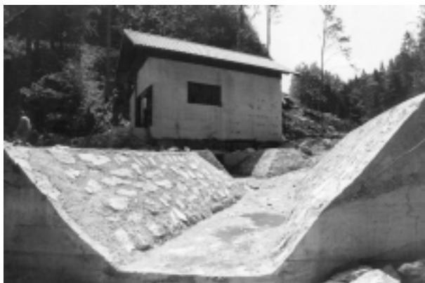
1987 Hidroelektrarna Davča (na sliki) z dvema generatorjema moči 270 kW je bila zgrajena leta 1987. Istega leta je bila rekonstruirana tudi hidroelektrarna Rudno (zgrajena leta 1935) z generatorjem moči 175 kW – Foto: Drago Papler
