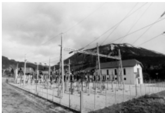
1989 Gradnja razdelilne transformatorske postaje Tržič 110/20 kV, na Loki – Foto: Drago Papler
