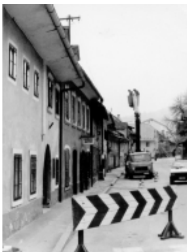
1988 Z avtodvigalom so delavci nadzorništva Škofja Loka demontirali dotrajane vodnike in strešna stojala, ki so že odslužila svojemu namenu – Foto: Drago Papler
