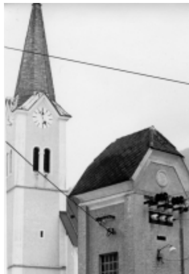
1992 Transformatorska postaja Križna tik pred rušenjem – Foto: Drago Papler
