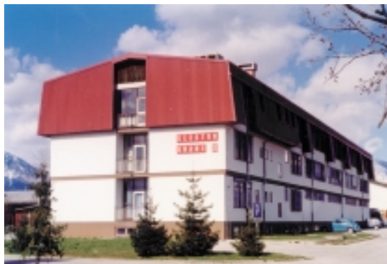
Nadzidava upravne stavbe TOZD Elektro Kranj na Primskovem v letih 1985–1986 – Foto: Drago Papler
