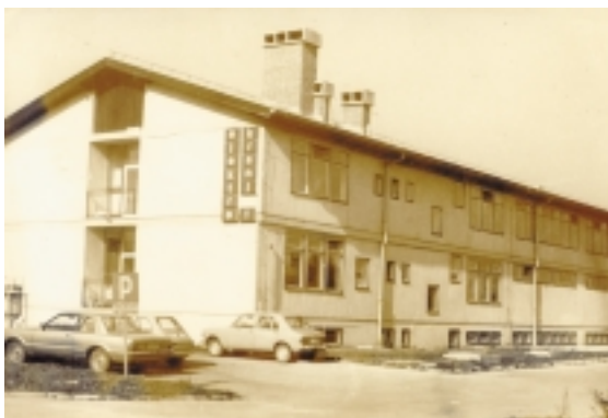
1967 Zgradba uprave Distributivne enote Kranj – Arhiv: Drago Papler
