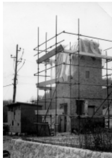
V času predelave transformatorske postaje – TP Dolenja vas Podbrezje in montaže 20 kV opreme je napajanje odjemalcev potekalo preko provizorične blindirne montažne transformatorske postaje – Foto: Drago Papler
