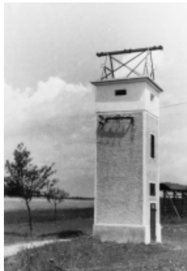
1941 Transformatorsko postajo v Senici je zgradila Elektrarna za Škofjo Loko in okolico d.d., potem jo je prevzela Elektrarna Majdič – Foto: Mile Vozel (1941), arhiv: Drago Papler
