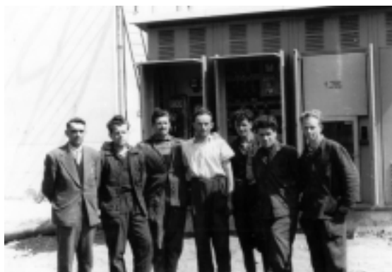
1958 Monterji Elektra Kranj ob montaži TP Planina – Arhiv: Drago Papler
