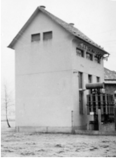
1964 Julija 1964 je bila svečano izročena namenu RTP Škofja Loka 35/10 kV z močjo 3x8 MVA in 35 kV napajalni daljnovod HE Medvode – Škofja Loka – Arhiv: Drago Papler
