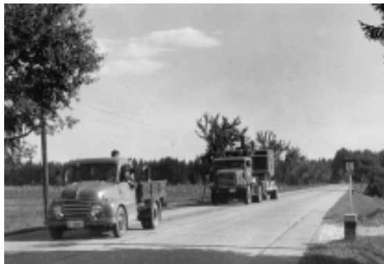
1961 Prevoz transformatorja – Arhiv: Drago Papler
