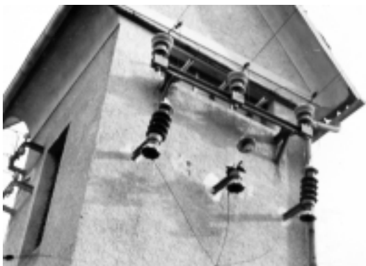
1948 Dovod daljnovoda v stolpasto transformatorsko postajo – Arhiv: Drago Papler
