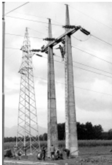
1954 35 kV betonski daljnovod Kleče – Moste – Arhiv: Drago Papler
