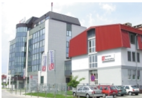
2000 Nova upravna stavba Elektro Gorenjska d.d. na Ulici Mirka Vadnova 3a na Primskovem v Kranju – Foto: Drago Papler
