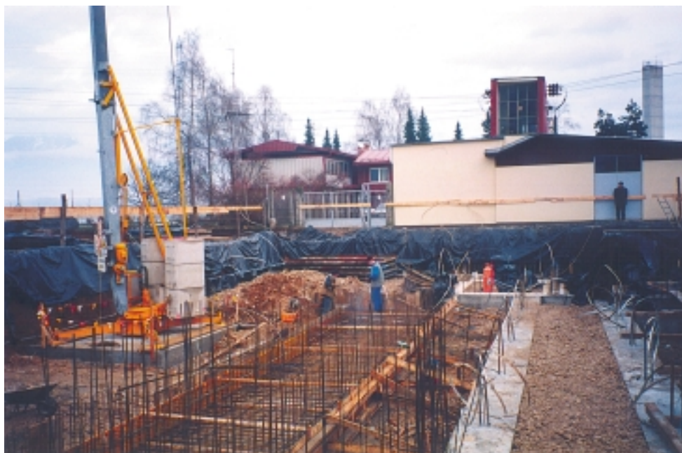
Gradbena jama RTP 110/20 kV Zlato polje, v ozadju obstoječi RTP 35/10 kV in distribucijski center vodenja Elektra Gorenjska – Foto: Tomaž Jamnik
