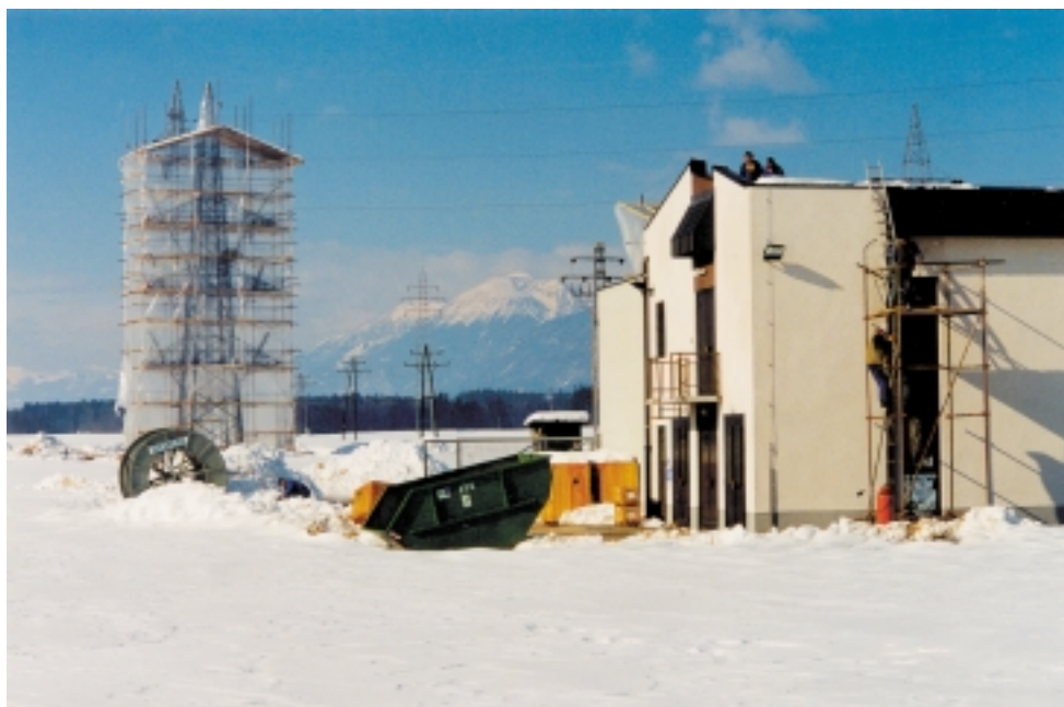
Gradnja razdelilne transformatorske postaje 110/20 kV Zlato polje v Kranju, januar 1999 – Foto: Tomaž Jamnik
