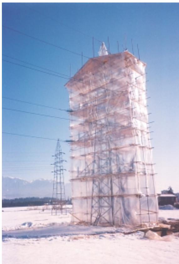
Vključevanje RTP Zlato polje s 110 kV polietilenskimi kabli v 110 kV kranjsko zanko RTP Zlato polje – RTP Okroglo in RTP Zlato polje – RTP Primskovo – Foto: Drago Papler
