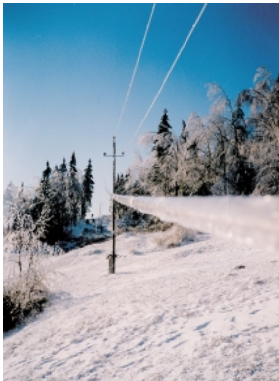
Ledeni objem na 20 kV daljnovo- du Podblica – Lajše, december 1996 – Foto: Drago Papler
