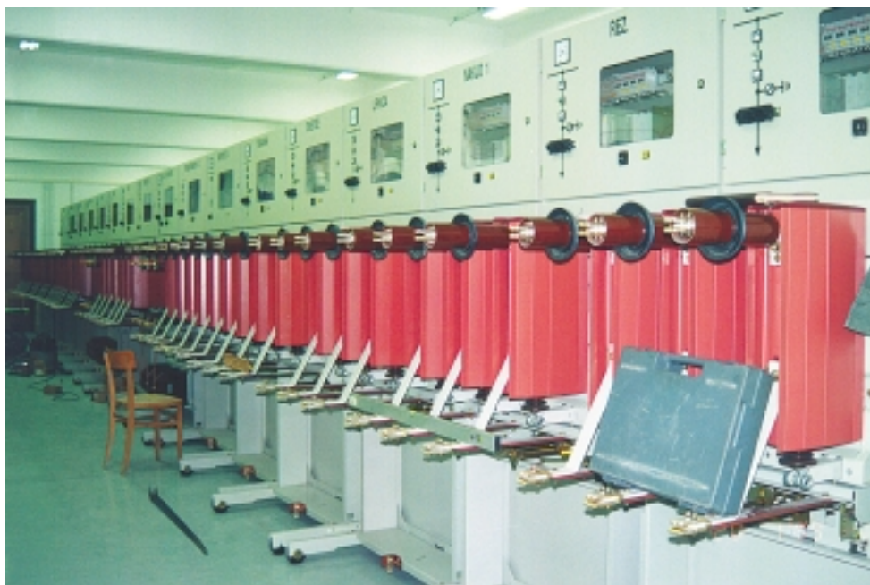
20 kV stikališče v RTP 110/20 kV Zlato polje – Foto: Tomaž Jamnik
