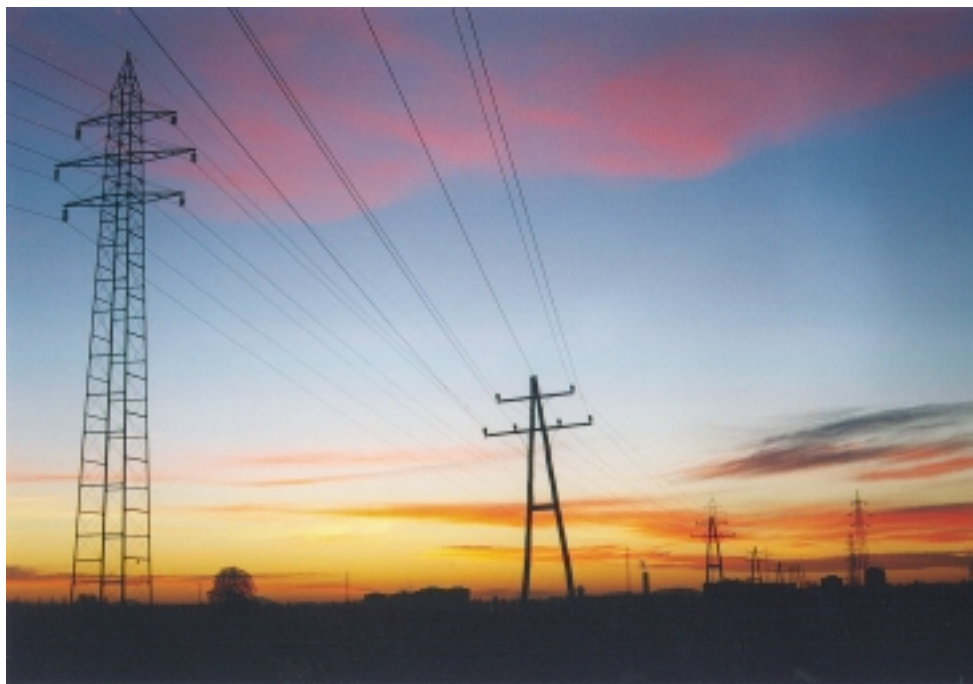
Koridor elektroenergetskih vodov na kranjskem polju v smeri Naklo – Foto: Drago Papler
