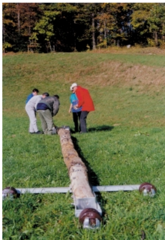
Gradbena skupina Kranj pri armiranju droga za 20 kV daljnovod Zanjivec – Kabinska žičnica Krvavec, oktober 1999 – Foto: Drago Papler
