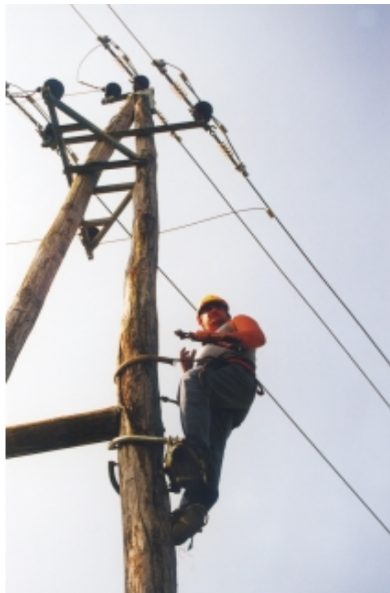
Elektromonter pri vzdrževanju 20 kV daljnovoda, odcep za letališče Brnik – Foto: Drago Papler
