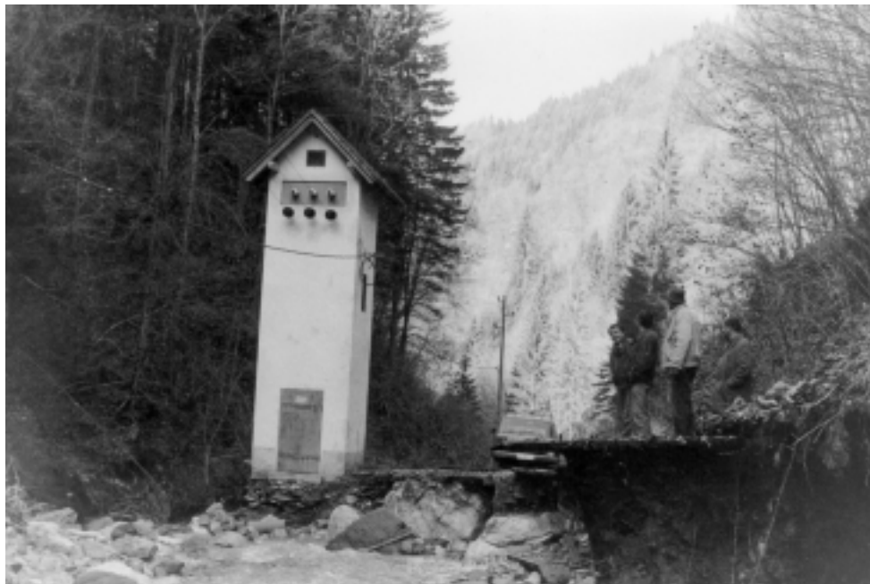
Hudournik Zgornja Smoleva je spremenil strugo in ogrozil transformatorsko postajo Jesenovec, november 1990 – Foto: Drago Papler
