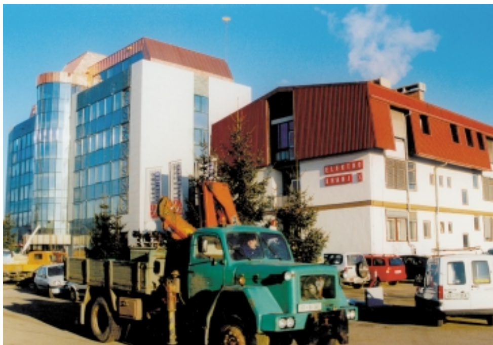
Prevoz transformatorja s skladišča na Primskovem na delovišče – Foto: Drago Papler
