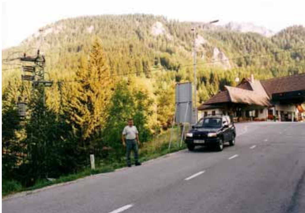
Slika 48: Transformatorska postaja na mednarodnem mejnem prehodu Jezersko, leta 2001 Vir: Fotografija dr. Draga Paplerja
