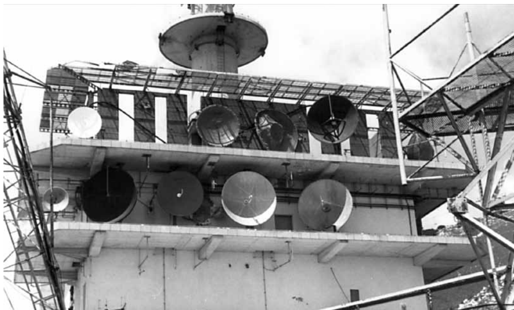
Slika 97: Naprave za sprejem in oddajanje radijskih in televizijskih signalov na Krvavcu Vir: Arhiv dr. Draga Paplerja
