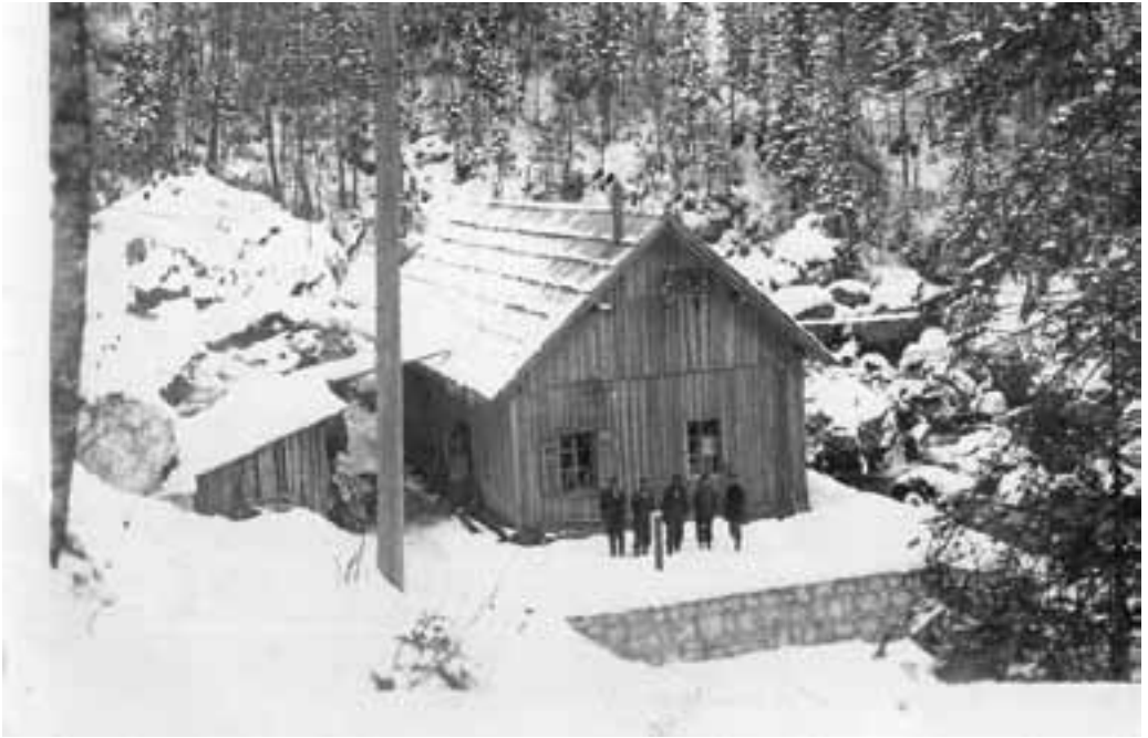
Slika 7: Prva hidroelektrarna Savica, december 1945 Vir: Arhiv Simona Cvetka
