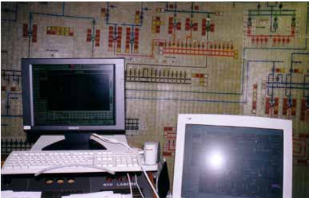
Slika 35: Izdajanje komand s sinoptične plošče je postopoma prevzel računalnik v DCV Elektra Gorenjska Kranj Vir: Fotografija dr. Draga Paplerja
