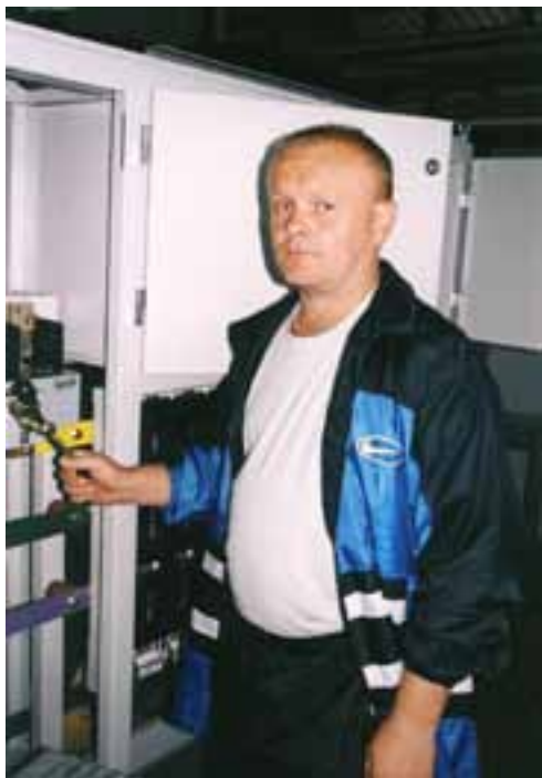
Slika 105: Elektromonter Zdravko Udir je iz montažne delavnice Elektra Kranj odšel na intervencijsko zamenjavo transformatorjev na Krvavec, 2. julija 1991 Vir: Fotografija dr. Draga Paplerja
