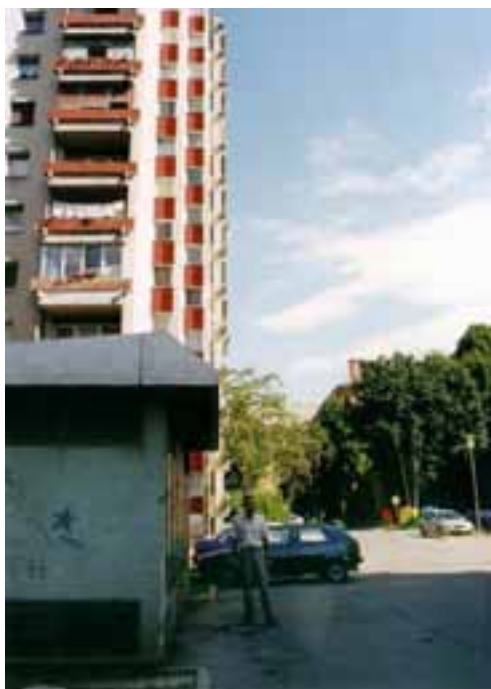
Slika 55: Transformatorska postaja Stolpnice Škofja Loka Vir: Fotografija dr. Draga Paplerja
