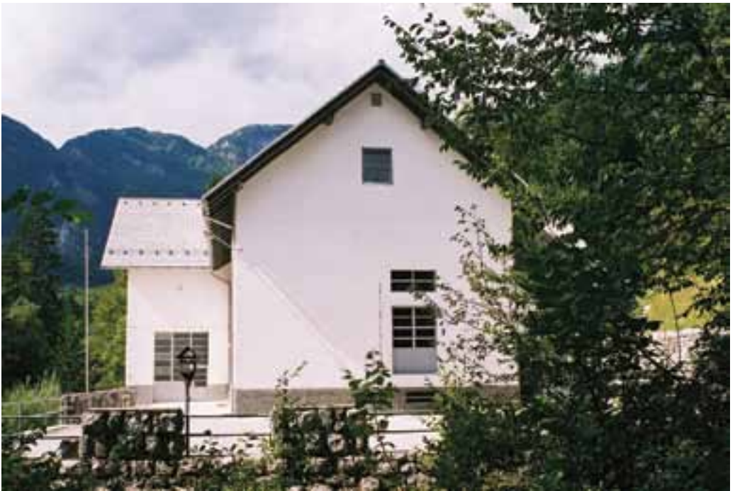
Slika 8: Stavba hidroelektrarne Savica, v kateri je bilo v letih 1990 in 1991 tajno skladišče orožja Vir: Fotografija dr. Draga Paplerja
