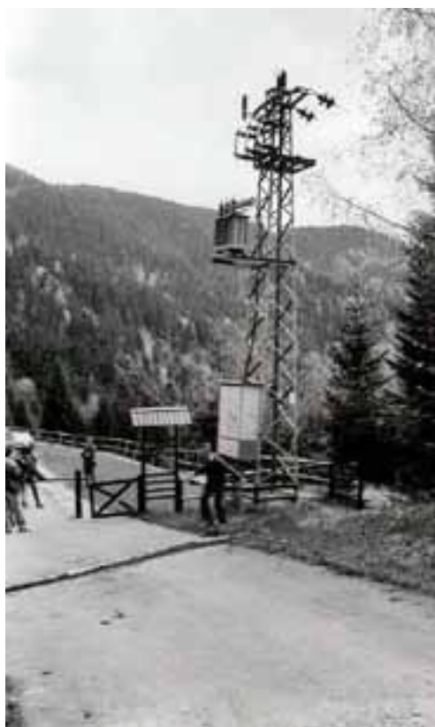
Slika 63: Mejni prehod Rateče je bil med osamosvojitveno vojno z odklopom v transformatorski postaji brez elektrike, vode in hrane Vir: Fotografija Janeza Šorlija
