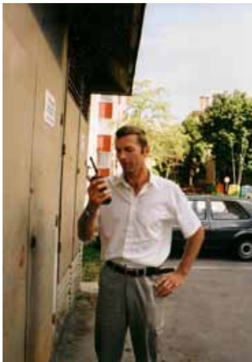
Slika 57: Bojan Luskovec pri transformatorski postaji Stolpnice v Škofji Loki Vir: Fotografija dr. Draga Paplerja
