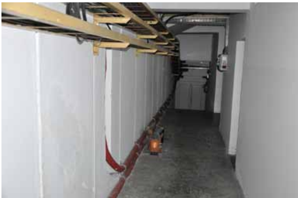
Slika 12: Kletni prostori pod strojnico hidroelektrarne Savica, kjer je bilo tajno skladišče orožja Vir: Fotografija dr. Draga Paplerja
