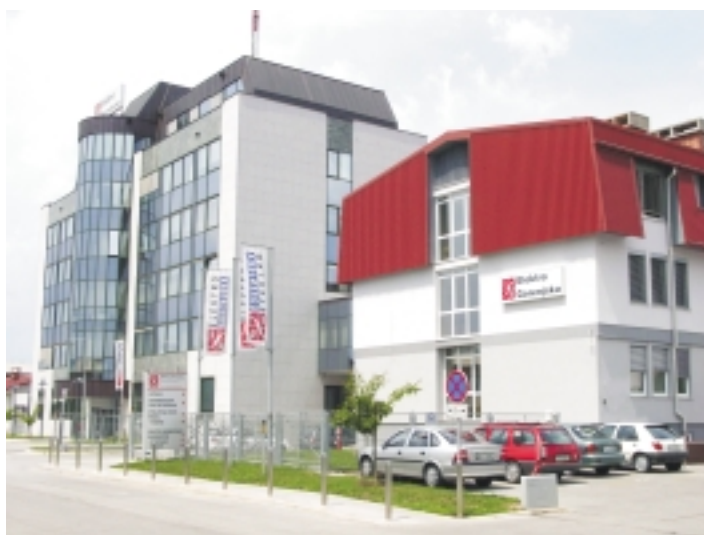
Poslovna stavba Elektro Gorenjska d.d.
