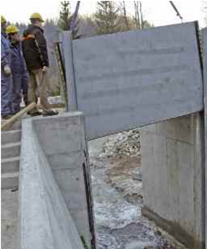
Montaža izpustne zapornice na jezju HE Lomščica.
