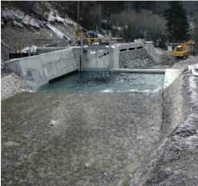
Gradbena dela na novem zajetju HE Lomščica so bila februarja 2008 v zaključni fazi.
