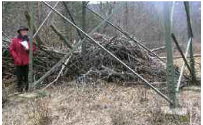
Odgovorni nadzornik Lojze Zupanc na ogledu.
