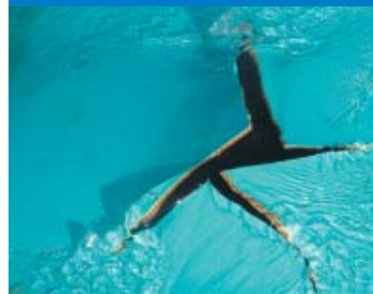
Poškodba mehkega jezua
