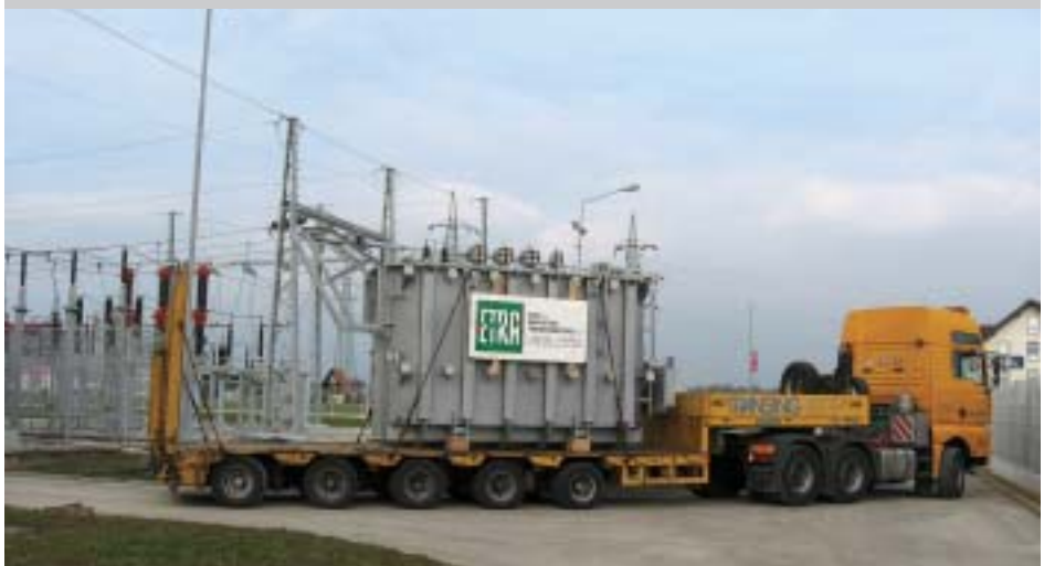
Menjava transformatorja 110/20, 31,5 MVA v RTP Primskovo. Foto: Gaber Resman.
